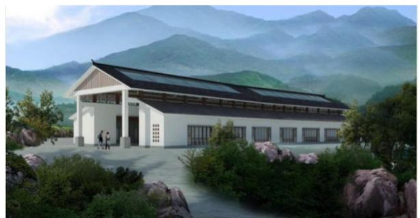
回站和第二段索道的迂回张紧站布置在这里，索道详细设计时站房可根据地形设计，尽量减少开挖施工量。中间站房±0:00 以下有架空层，详细设计时，建设方可以根据地形有效、合理的利用架空层布置其他功能设施。中间站为第一段索道和第二段索道的转向站，两条索道中心线转弯角约 95°。
