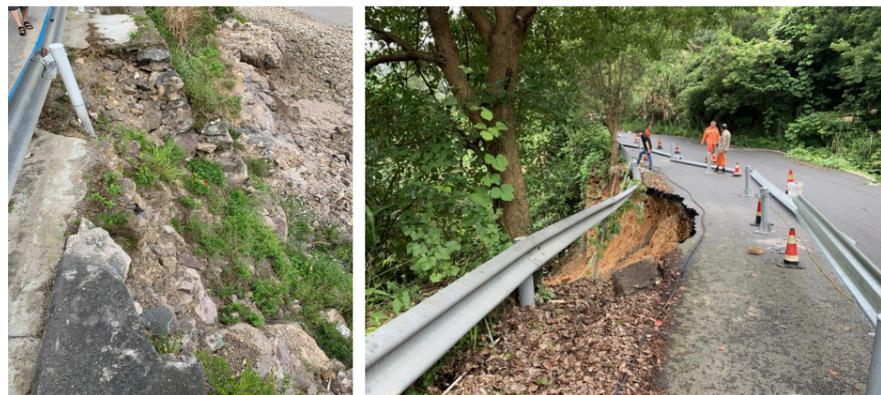
4. 路面排水：龙魁线 K36+400-K36+760、K48+321-K48+366 和 K49+950-K50+005 及灵溪线 K0+600-K0+700 共计 4 段路侧排水边沟堵塞严重或未设置，路侧积水严重。
