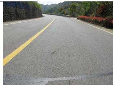
裂缝修补及坑槽
